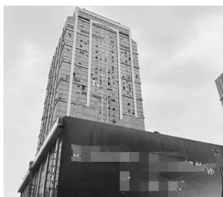
前处于「烂尾」 金运大厦外部,目前
